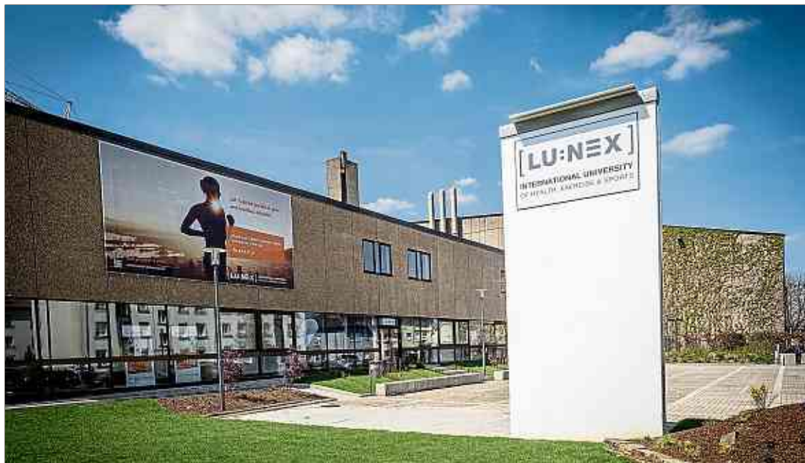
Vor dem ehemaligen Schwimmbad soll das Studentenhotel errichtet werden. (FOTO: CLAUDE PISCITELLI/LW-ARCHIV)
