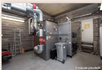
Fröling Turbomat 400 kW
