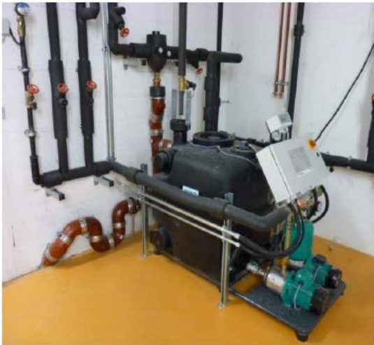
Regenwasserdruckstation
