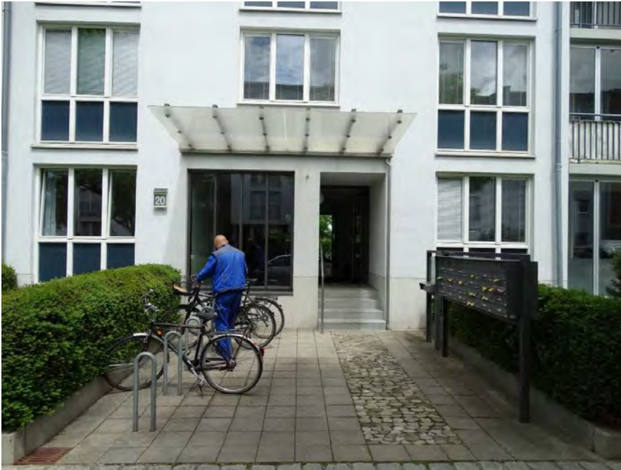
Freiburg Rieselfeld Willy Brand Allee n° 20
